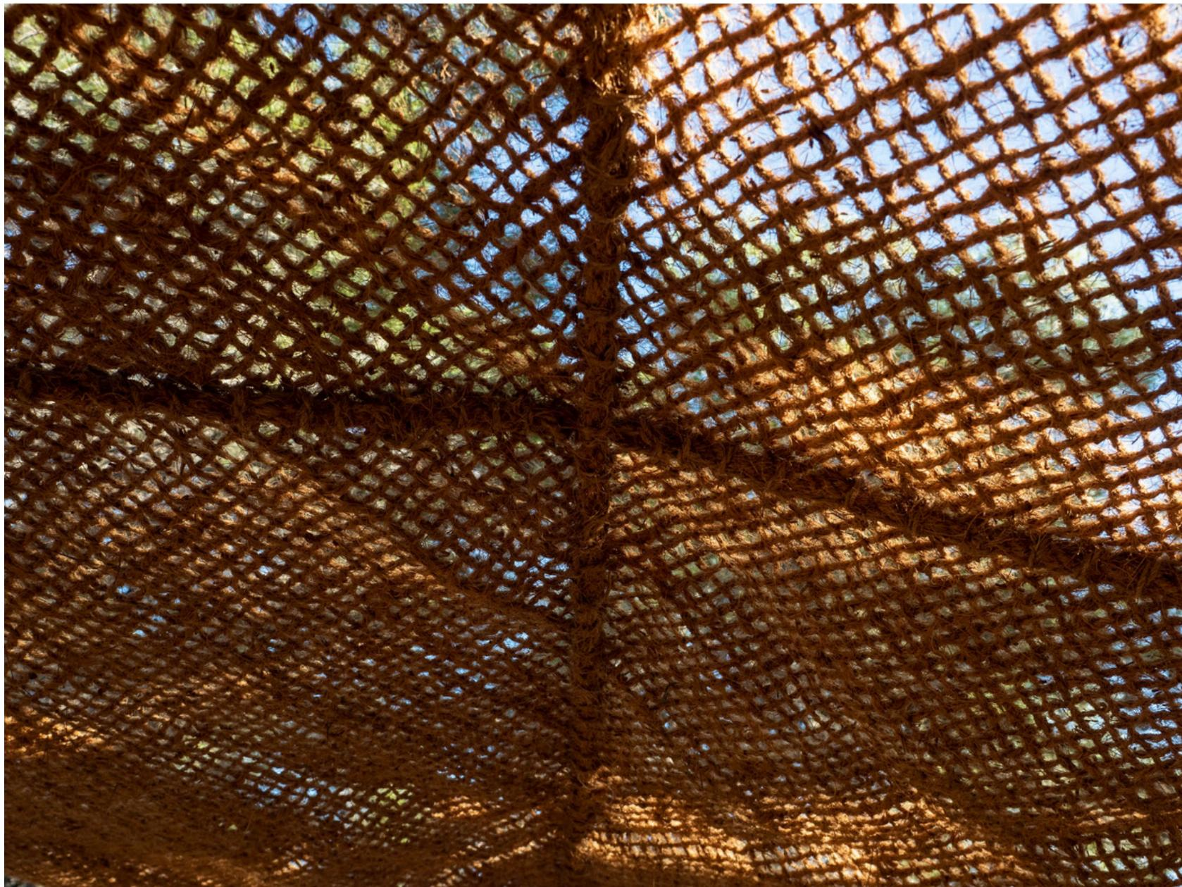
**Important :** Pour un résultat optimal, les cordes d'attache doivent être dans l'alignement des cordes de renforcement, veiller à ce que les cordes de soutien de l'ombrière soient orientées vers le bas.
